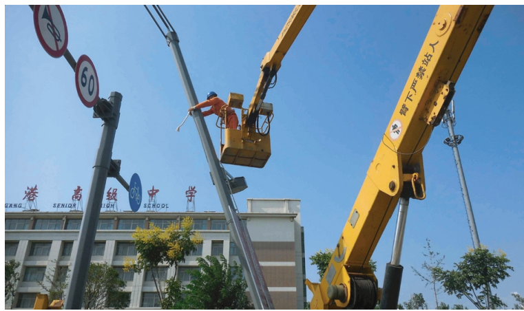
连日来，华茂瑞泰服务公司路灯维修班组在加大路灯昼夜巡查工作力度的同时，对辖区内路灯设施进行“拉网式”检查，查找安全隐患，发现一处及时整改一处，确保设施安全运行和路灯亮化率。（叶茹）
